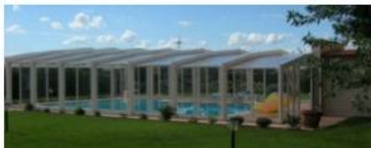
ESEMPIO DI COPERTURA TELESCOPICA
